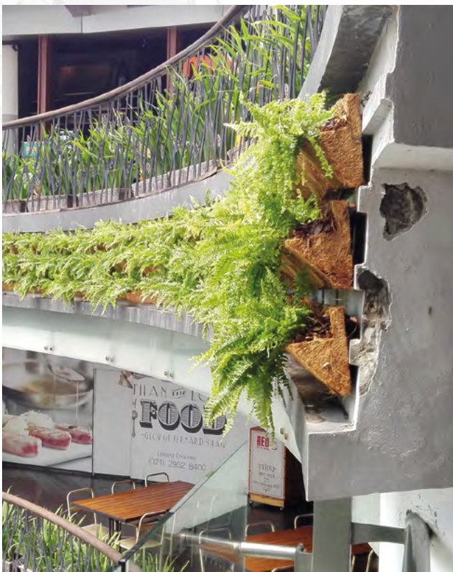
| Support en fibres de coco dans un centre commercial de Jakarta, Indonésie
