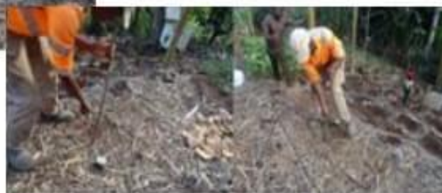
Implantation de la structure (1h).
