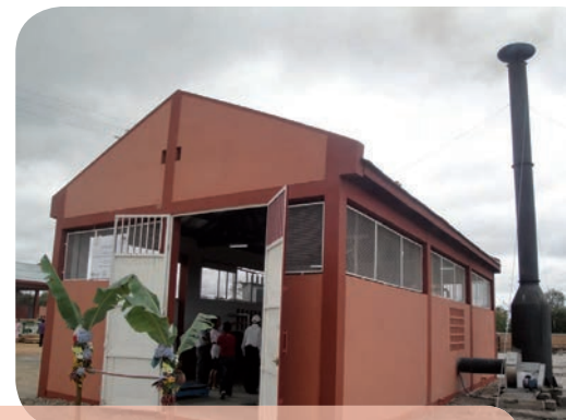
Centrale électrique de la ville d'Andaingo, alimentée par 60 ha de plantations d'eucalyptus, à Madagascar. © R. Peltier/Cirad
