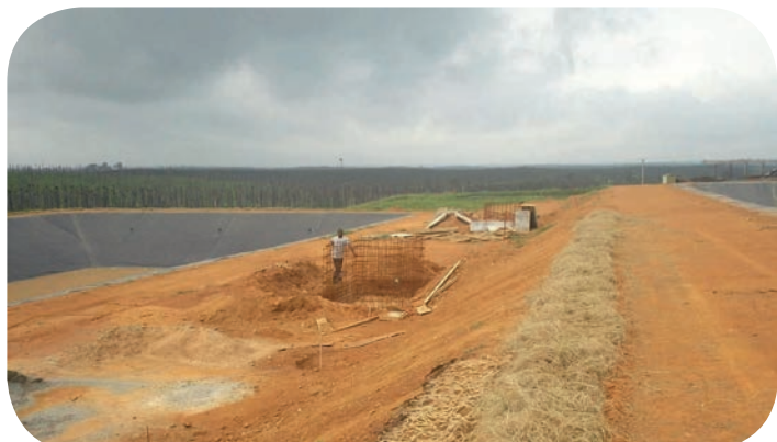
Construction de lagune de méthanisation au Ghana. © Biotec
