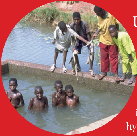
Ouvrage régulateur d'eau au Mali. © E. Daou.
