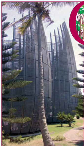
Centre J.-M. Tjibaou, structure lamellé-collée en Iroko (Nouvelle-Calédonie).
